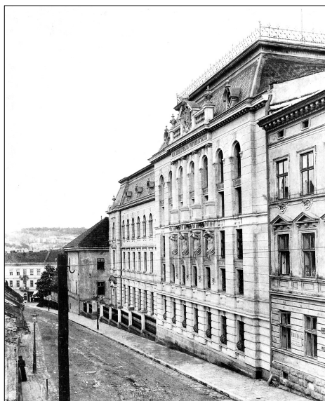
Бібліотека Львівського університету на вул. Мохнацького (тепер вул. Драгоманова, 5), 1905 р.
